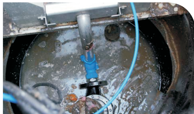
Rys. 4. Uzbrojenie przepompowni przydomowej WILO
